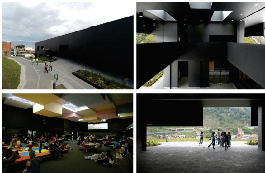
FIGURA 21 – Vistas da biblioteca Fernando Botero Fonte: ARCHDAILY (2015)
